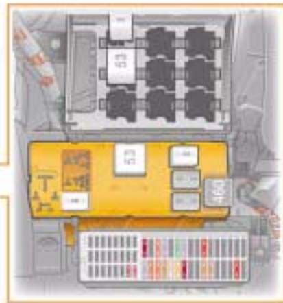
Relaisträger am Steuergerät für Bordnetz, unter der Schalttafel links
